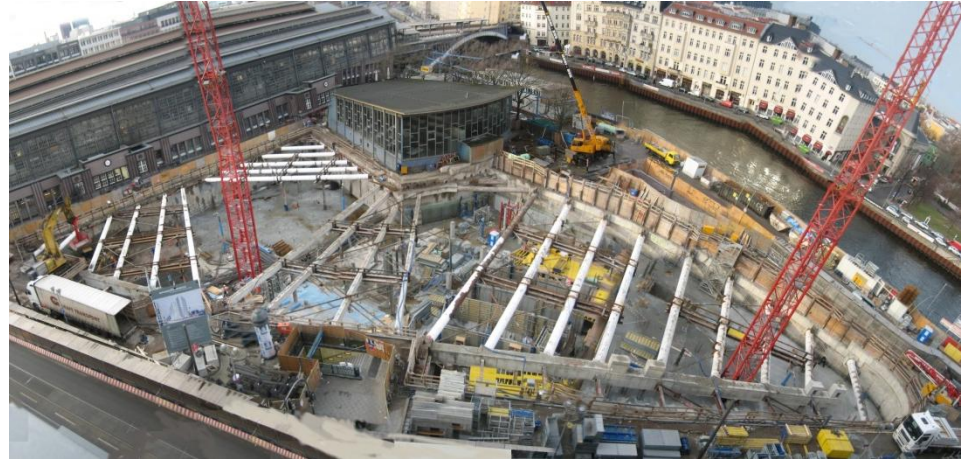
Baugrube – Spreadreieck, Berlin
