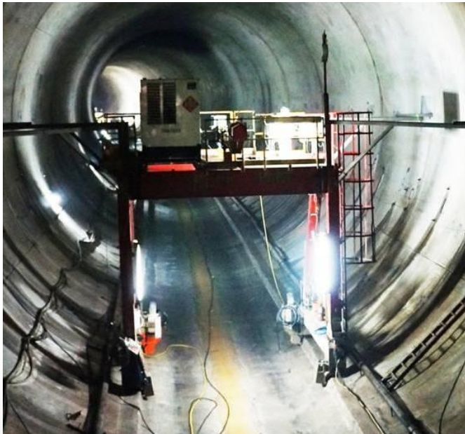
Injektionsarbeiten - Niagara Falls
